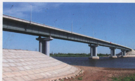
Мост через р. Кигач на автомобильной дороге Астрахань - Атырау
