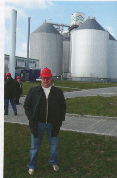
Составляющая очистных сооружений (метантехники)
