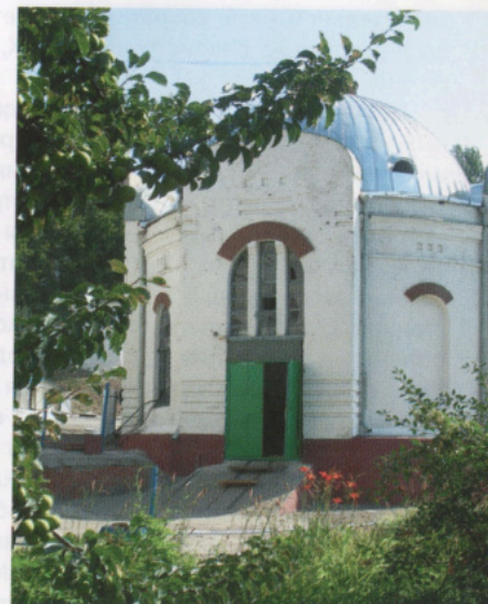
Водопроводная насосная станция 1-го подъема № 1
