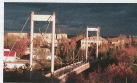
Мост через р. Кама у с. Сорочьи горы в Татарстане (1-я очередь строительства)
