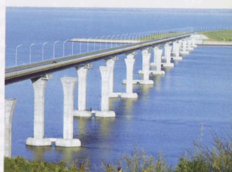
Мост через р. Кама у с. Сорочьи горы в Татарстане (1-я очередь строительства)
