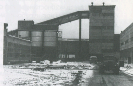
1970 год. Есть первый бетон!
