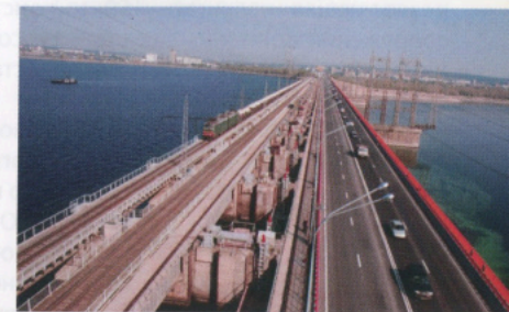
Мост через р. Волга по водосливной плотине Волжской ГЭС
