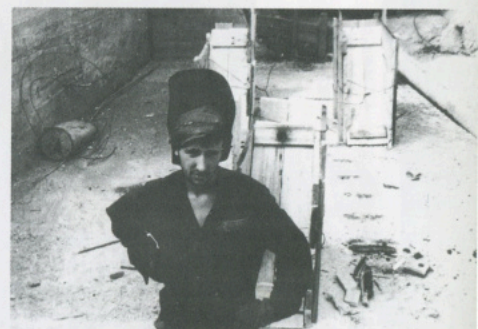
1979 г., стройотряд строительного факультета, ударная комсомольская стройка, Залетаевские очистные сооружения, Заводской район, г. Саратов.
