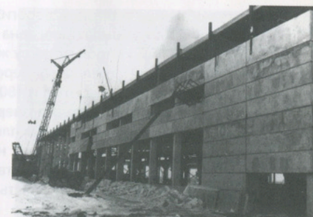
1968 год. Строительство главного корпуса
