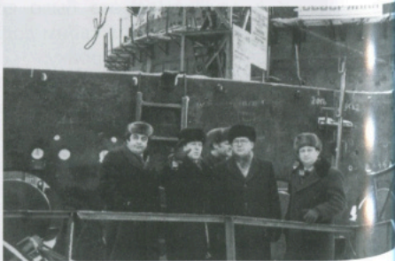
Г. Череповец, А. А. Бабенко – Первый заместитель министра – на строительстве самой крупной в мире домны «Северянка»
