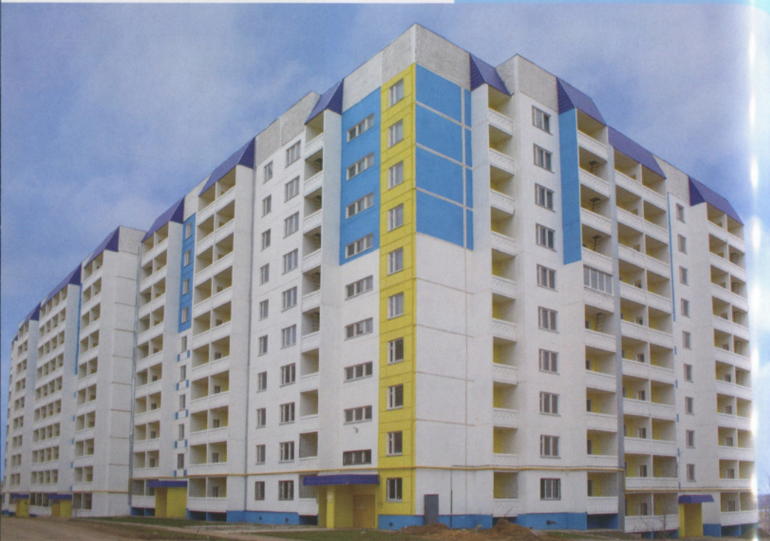
Дом по ул. Днепропетровская, п. Солнечный
