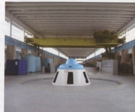
Машинный зал. Ремонт Саратовской ГЭС.
