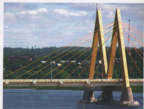
Вантовый автодорожный мост через р. Казанка по IV транспортной дамбе в Казани
