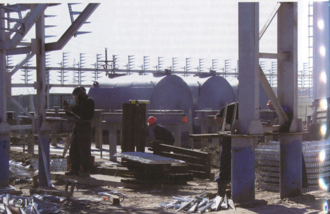
Строительство на полуострове Ямал.
