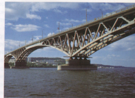
Городской автомобильный мост Саратов-Энгельс через р. Волга
