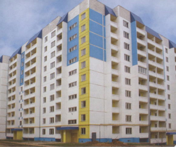
Жилой дом, ул. Днепропетровская, п. Солнечный
