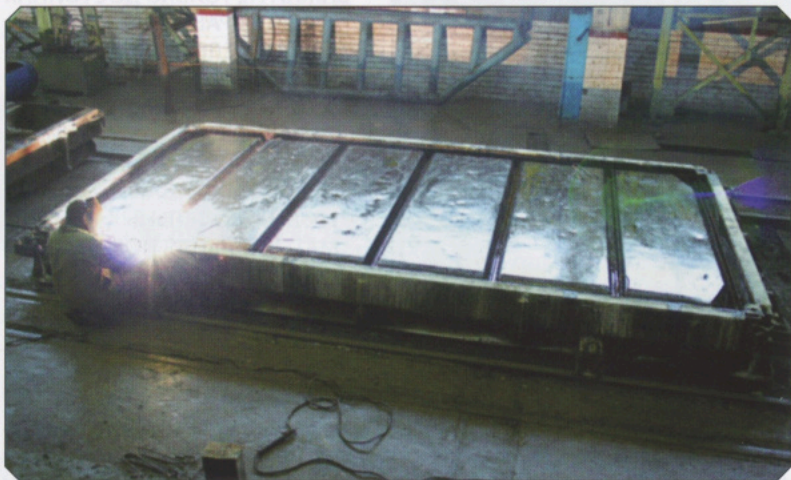
Формовочный цех по производству наружных стеновых панелей на заводе крупнопанельного домостроения
