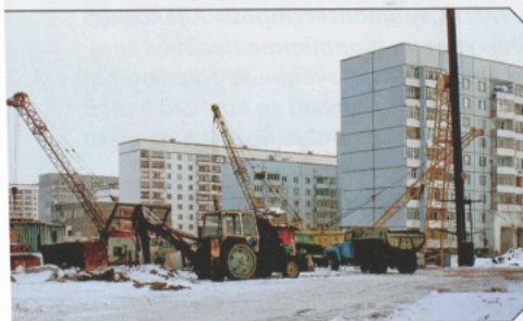
Строящийся жилой массив в 11-м микрорайоне
